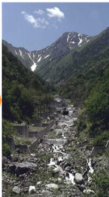
工事実施後(S62)
