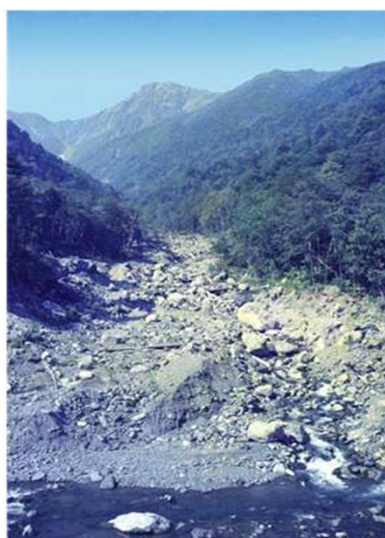
荒廃状況(S40)
