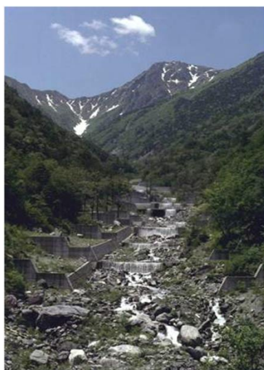
工事実施後(S62)
