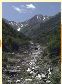
工事実施後（S62）
