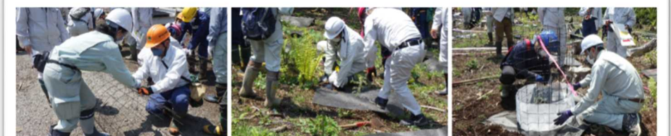
ワイヤーメッシュを丸めて成型 植生等を除去後に防草シートを敷設 単木柵設置後に寒冷紗を取り付け
