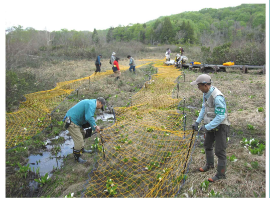
シカ防除ネットの設置
