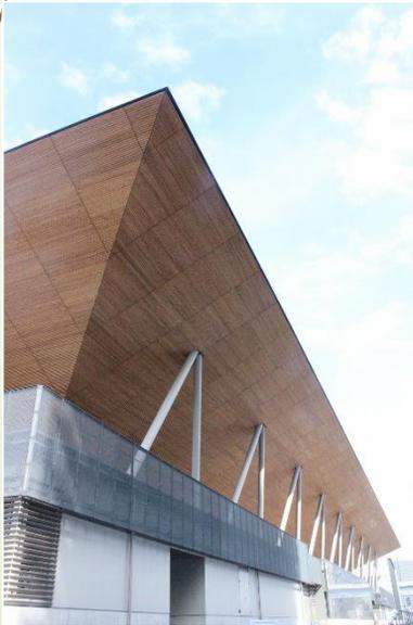
同競技場は五輪の新設会場で最大となる約23000立方メートルの木材を全国から集めて建てられ、外壁約800立方メートルのうち、426立方メートルには持続可能な森林管理の国際基準「FSC認証」を受けた天竜スギが使用されています。
