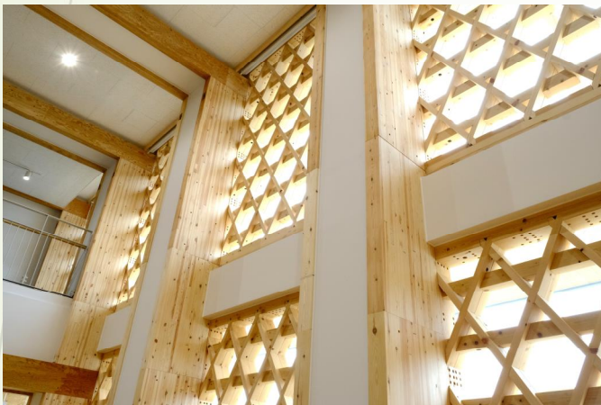
柱・梁と組子格子の立体感が光量を段階的に変化させて、空間にやすらぎを与えてくれます。
