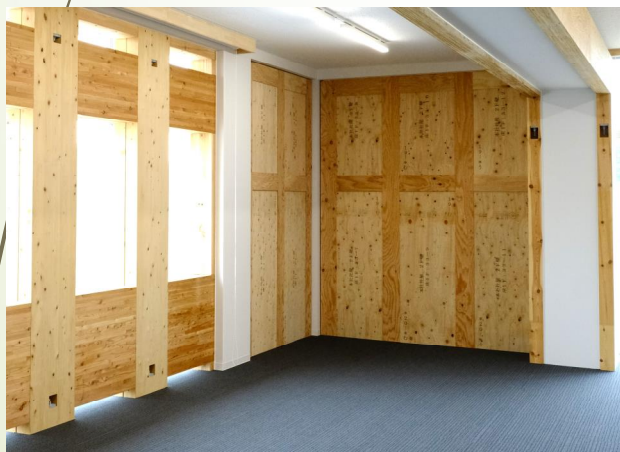
両面に24mm厚の国産針葉樹合板を張った壁倍率の合板耐力壁。釘ピッチを狭くしています。
