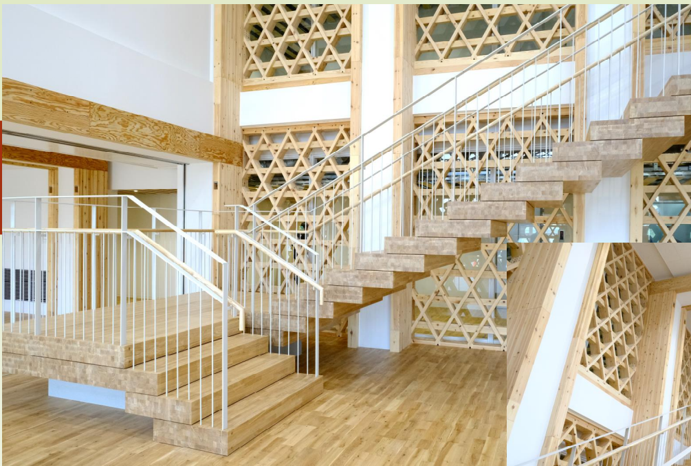
1階吹き抜けのエントランス。組子格子耐力壁のデザインと階段踏板の集成材が目を引きまます。
