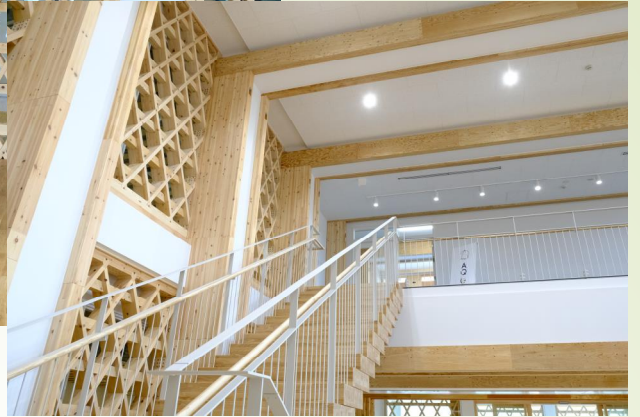
1階吹き抜けのエントランス。組子格子耐力壁のデザインと階段踏板の集成材が目を引きまます。
