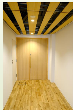
1階廊下。清潔感があふれ天井部のルーバーと床板の木質化にぬくもりを感じます。壁が白色で明るいのは不燃材料によるもので、延焼スピードを落とす工夫が施されています。
