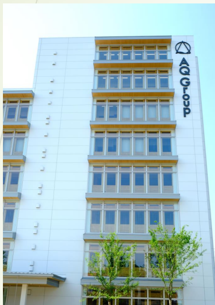
正面（南面）のガラスカーテンウォール
