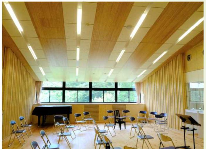
中央棟 音楽室。RC造ですが、音響効果を最大限に引き出せるように内装には表情の異なる木材を多様に使用しています。
