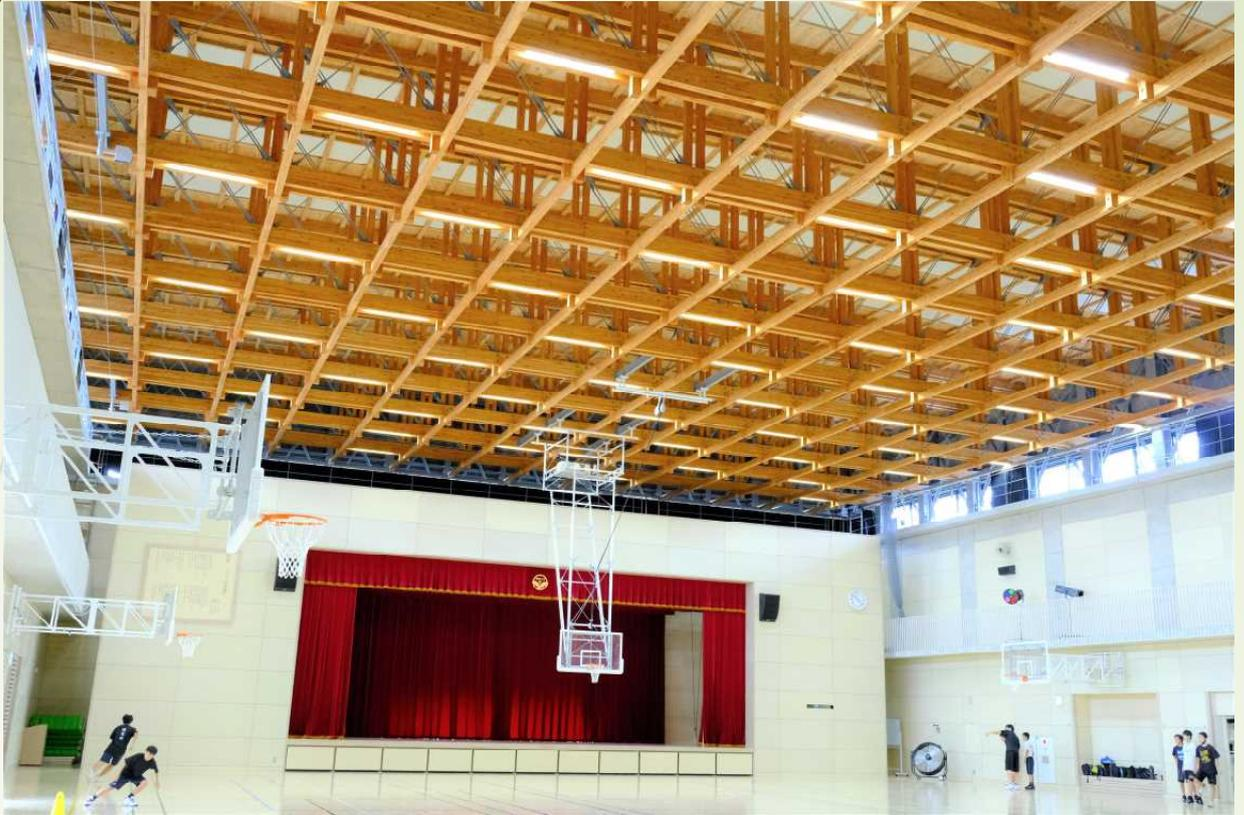
中央棟 体育館。立体組木トラスは一般的に流通している中断面の集成材（岩手近県のカラマツ）で構成されていて、約28.7mのスパンと約10mの水平な天井高を確保しています。輝く白い床はヨーロッパ産メイプルを使用し、ささくれの抑制加工を施しています。
