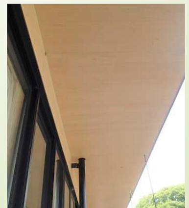
バルコニー床は、跳ね出しで厚180mmのヒノキのCLTを使用しています。外壁は5年経過時に塗替えを行い、その後10年を目安に繰り返し施工する計画です。
