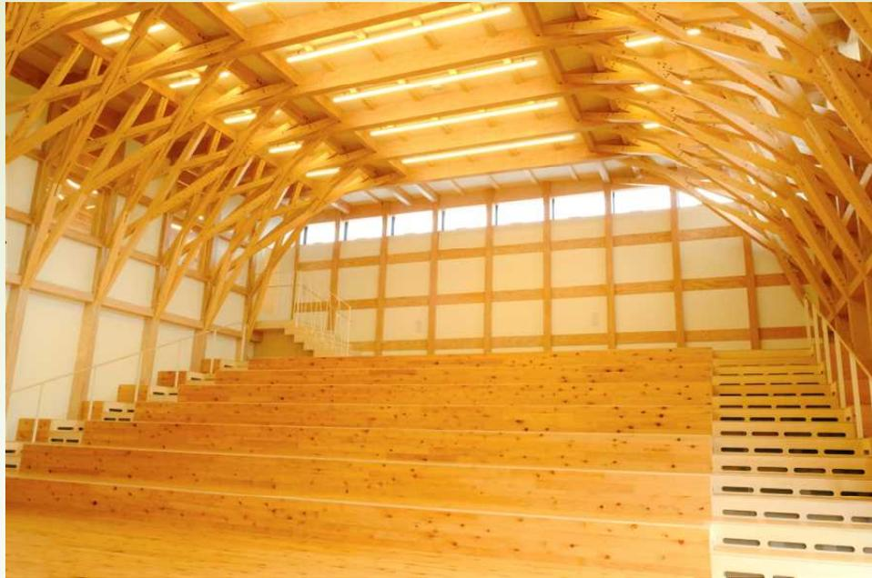
東棟 多目的ホール。平場のスペースから階段状の立ち上がり、樹状の木架構へと視線が移ることによって、樹林に包まれているような感覚になります。トラスのスパンは12m。
