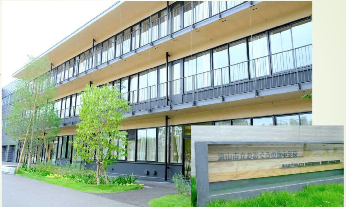
入口から見た校舎（西棟）。採光窓が連続し、黒を基調とした引き締まった外観と乳白色の木質部が洗練された印象を与えています。バルコニーの庇によって東西軸の校舎配置と変わらない日射負荷を実現しています。
