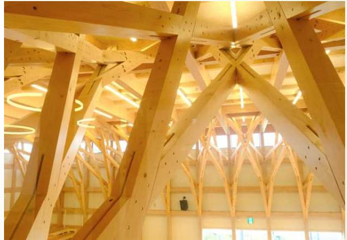
樹状方杖は、柱から2方向3段の立体架構として樹林を表現したデザインです。一般流通材である120mm角のヒノキ製材を使用していて、一部に厚9mmの鋼板を挿入して木架構とドリフトピンで接合し、剛性を確保しています。
