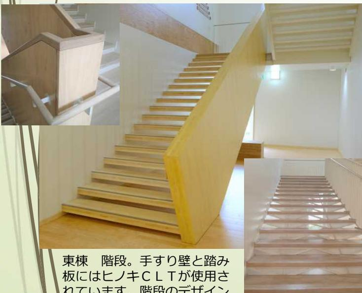
東棟 階段。手すり壁と踏み板にはヒノキCLTが使用されています。階段のデザインは3種類あるそうです。
