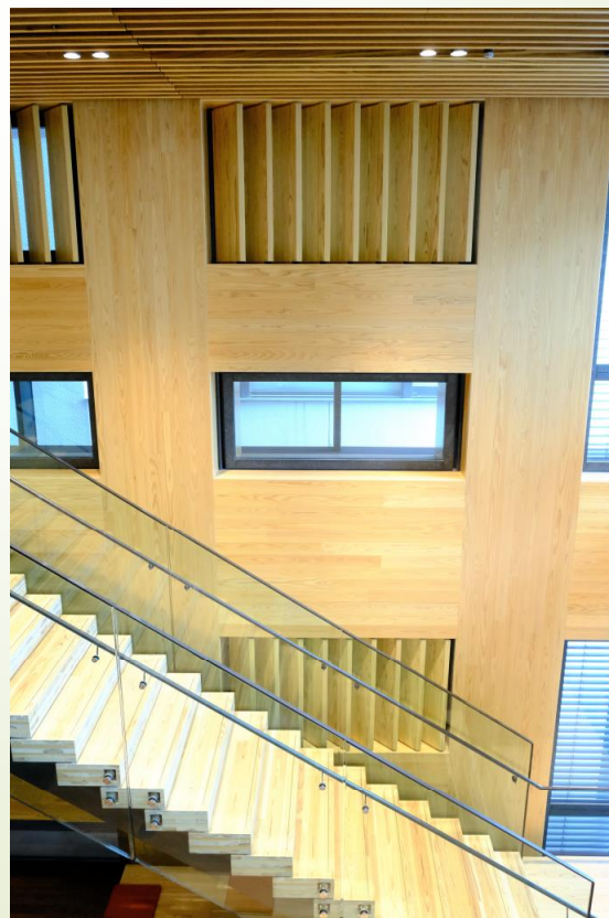
3階より2階吹き抜けを見る。剛接合仕口ユニットに中間梁が付いているのが分かります。
