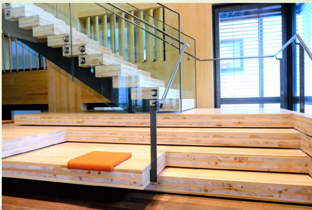
2階から3階(上部吹き抜け)への階段踏板もCLT(5層厚150mm)が使用されています。
