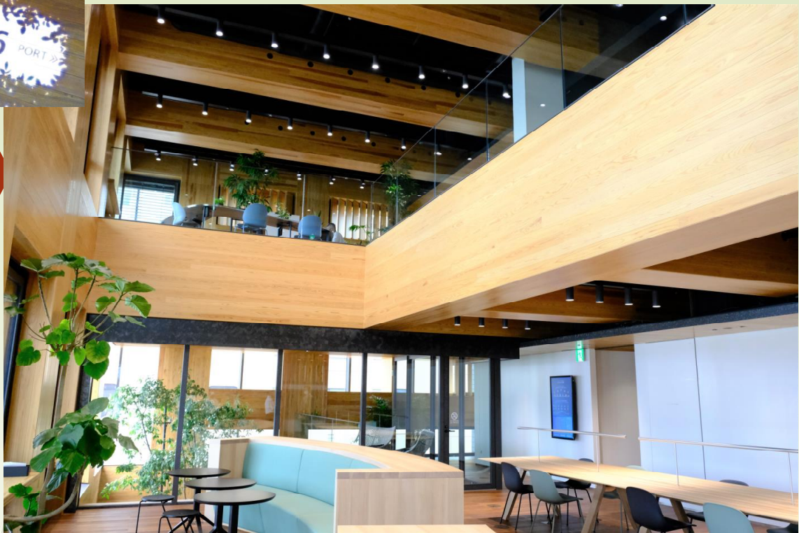
6階から7階を見上げる。開放感あふれる無柱空間の実現はラーメン構造の特性のひとつ。
