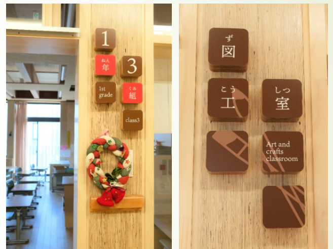
教室名を標示する部材も L V L で製作されています。取り外しが可能で、クラスの変動にも柔軟に対応できます。
