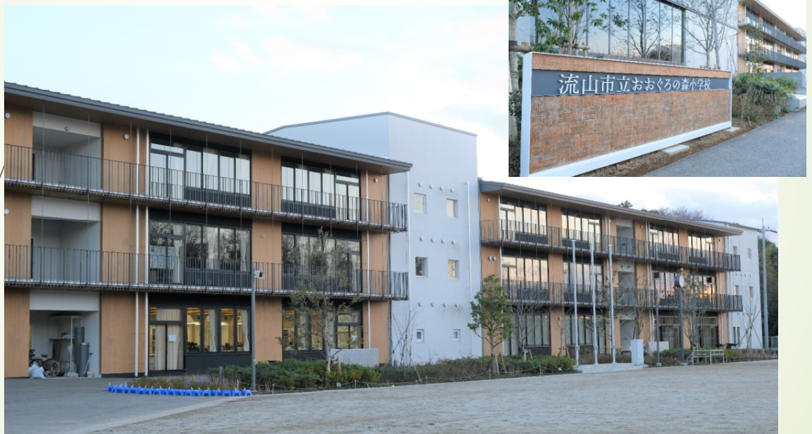
校庭から見た校舎の外観。中央の白いRC造は耐火接続棟として設置され、左右の3階木造部を3,000㎡以下に区画して準耐火構造を可能にしています。このことにより、外壁や内装材等の木材を「現し」で使用することができます。
