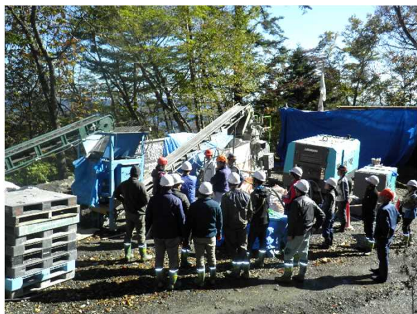
吹付に使用する機材の説明を聞く研修生
