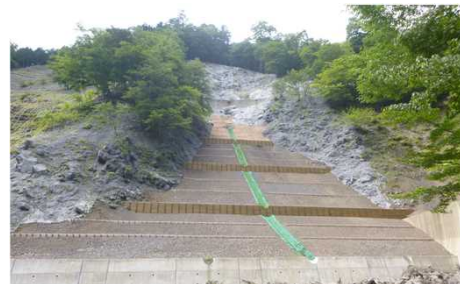
荒廃山地の復旧整備 (山腹工(土留工ほか)) 天竜署(静岡県浜松市)
