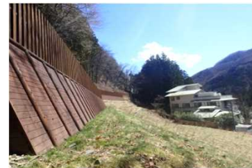
荒廃斜面における落石の防止(予防治山) 吾妻署(群馬県中之条町)
