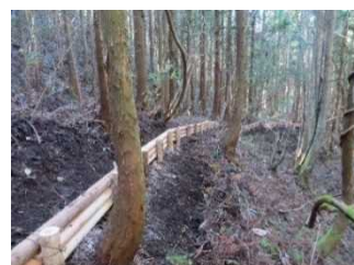
放射性物質の拡散防止対策(木柵工) 森林放射性物質汚染対策センター (福島県田村市)
