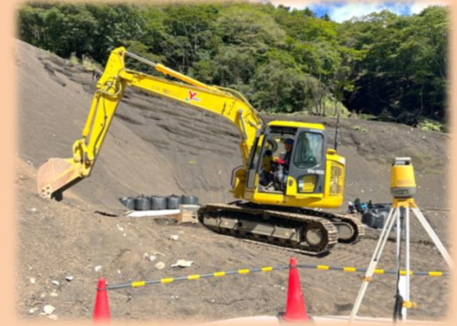
ICT建設機械を用いた掘削の様子
