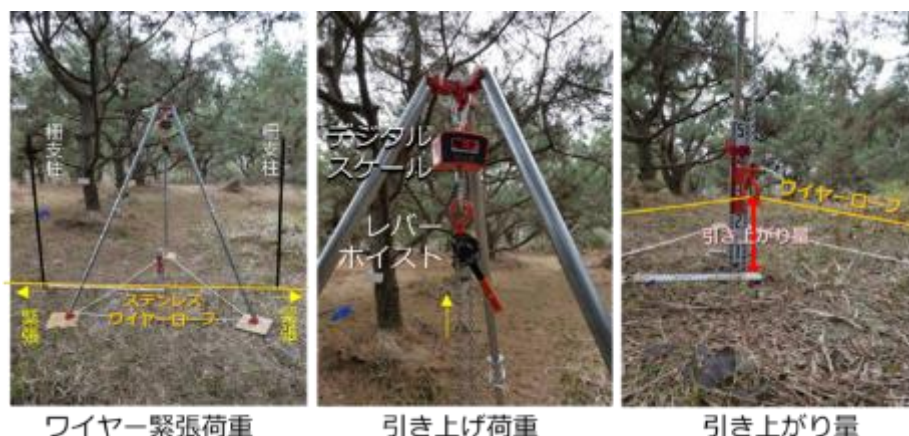
図ー7 ワイヤーロープの引き上げ荷重試験
