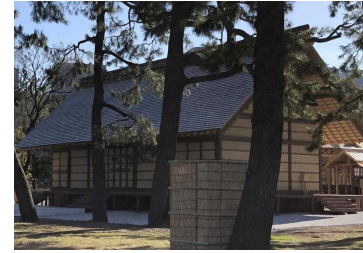
廻立殿の外壁に胴縁材として使用
