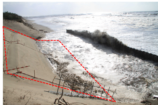
（写真-10）平成 27 年度施工箇所浸食被害
