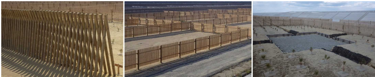
(写真-2) 各種対策工（左から丸太防風柵工、静砂垣工、浸透工）
