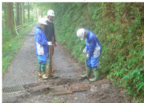
写真6：林道補修作業の様子
