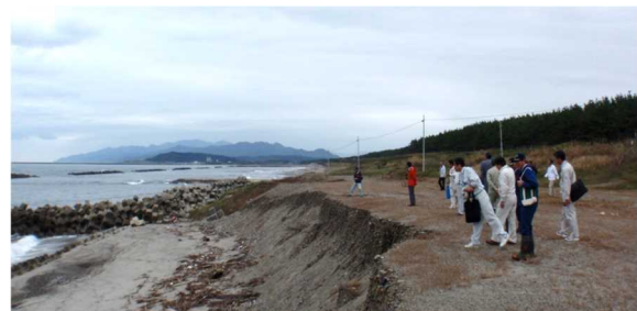
（写真-14）現地視察の様子
