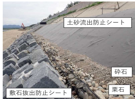
（写真-6）自然石被覆ブロックの設置
