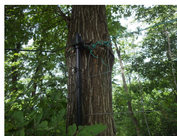
写真1. 立木支柱への巻き込み
