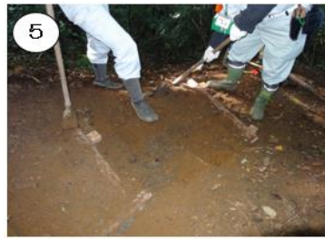
(写真 8-5 寄せた土を転圧)
