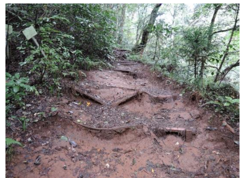
(写真2 劣化がみられる段差工)
