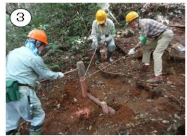
(写真 8-3 角材を垂直に設置)
