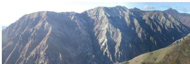
写真1. 観測監視地区の全景（平成17年撮影）
