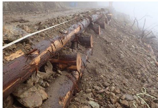
図5 路面補強工の実施
