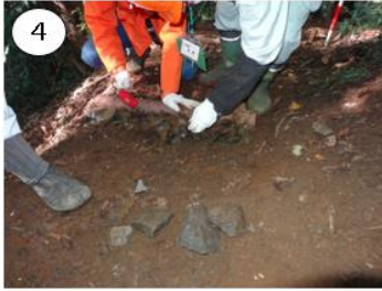
(写真 8-4 野面石を詰め込む)
