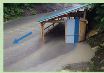
下流の天然温泉被災状況 (R3.8)
