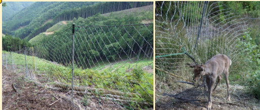
写真のようなネット柵は設置後にシカが絡まったり、倒木や落枝、土砂で流されたりと柵が損傷するおそれがあり、定期的なメンテナンスが必要。急傾斜地ではシカが柵を飛び越えて侵入する（将来は撤去が必要）
