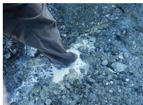
【写真3】崩壊地で発生する白濁水
