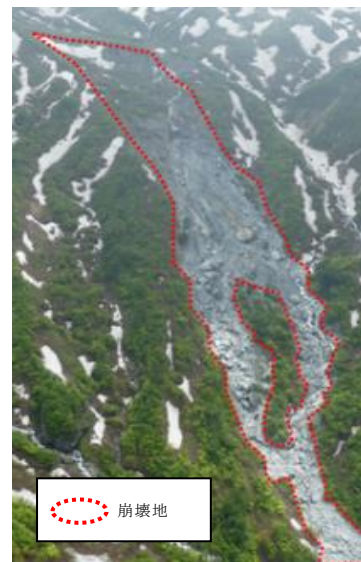
【写真1】小滝川上流の崩壊発生地
