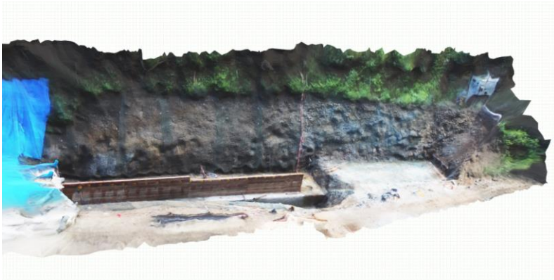
図一六 型枠組立て時の 3D モデル
