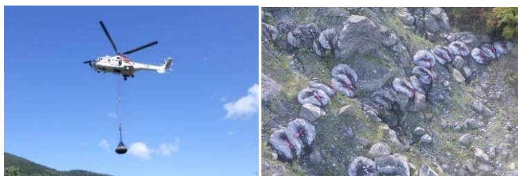
【写真 6】袋型石詰筋工設置状況
