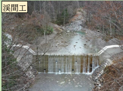
嵩上げ2基完了、1基新設中
