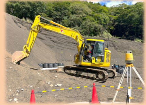
ICT建設機械を用いた掘削の様子
