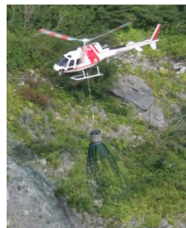
【写真4】緑化資材散布状況
