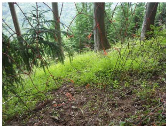
図-1 損傷したシカ柵の網
