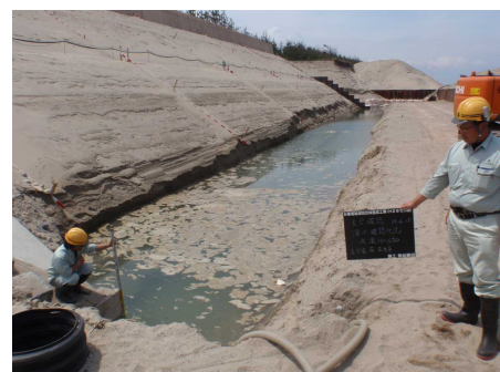
（写真-11）掘削時の湧水
