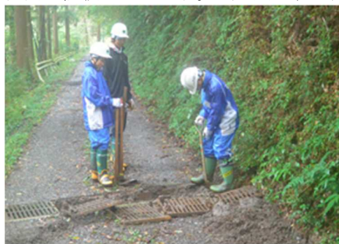
写真6：林道補修作業の様子
