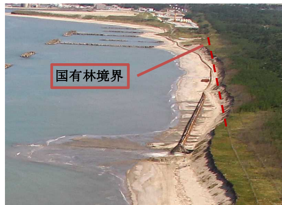
(写真-2) 国有林の浸食被害
