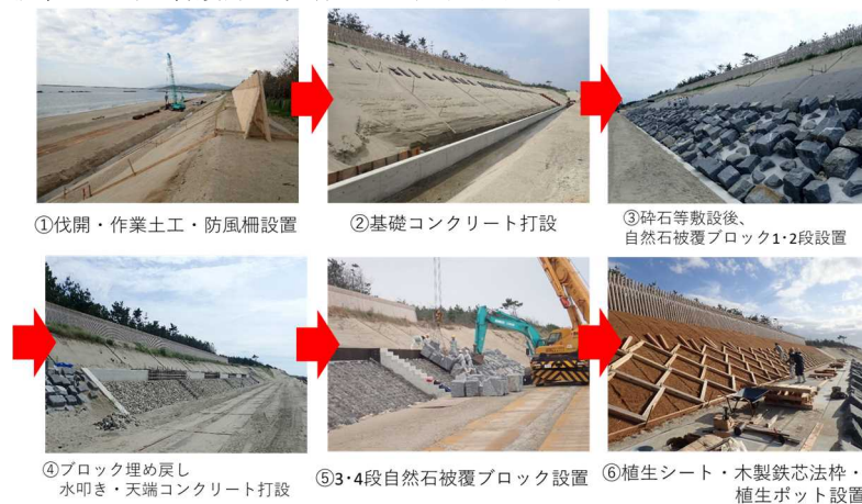
（写真-7）防潮護岸作業工程
