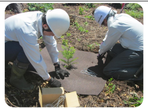
防草シートの設置作業
