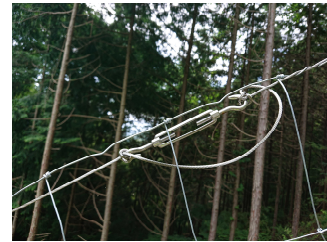
写真2. ターンバックルによる調節
