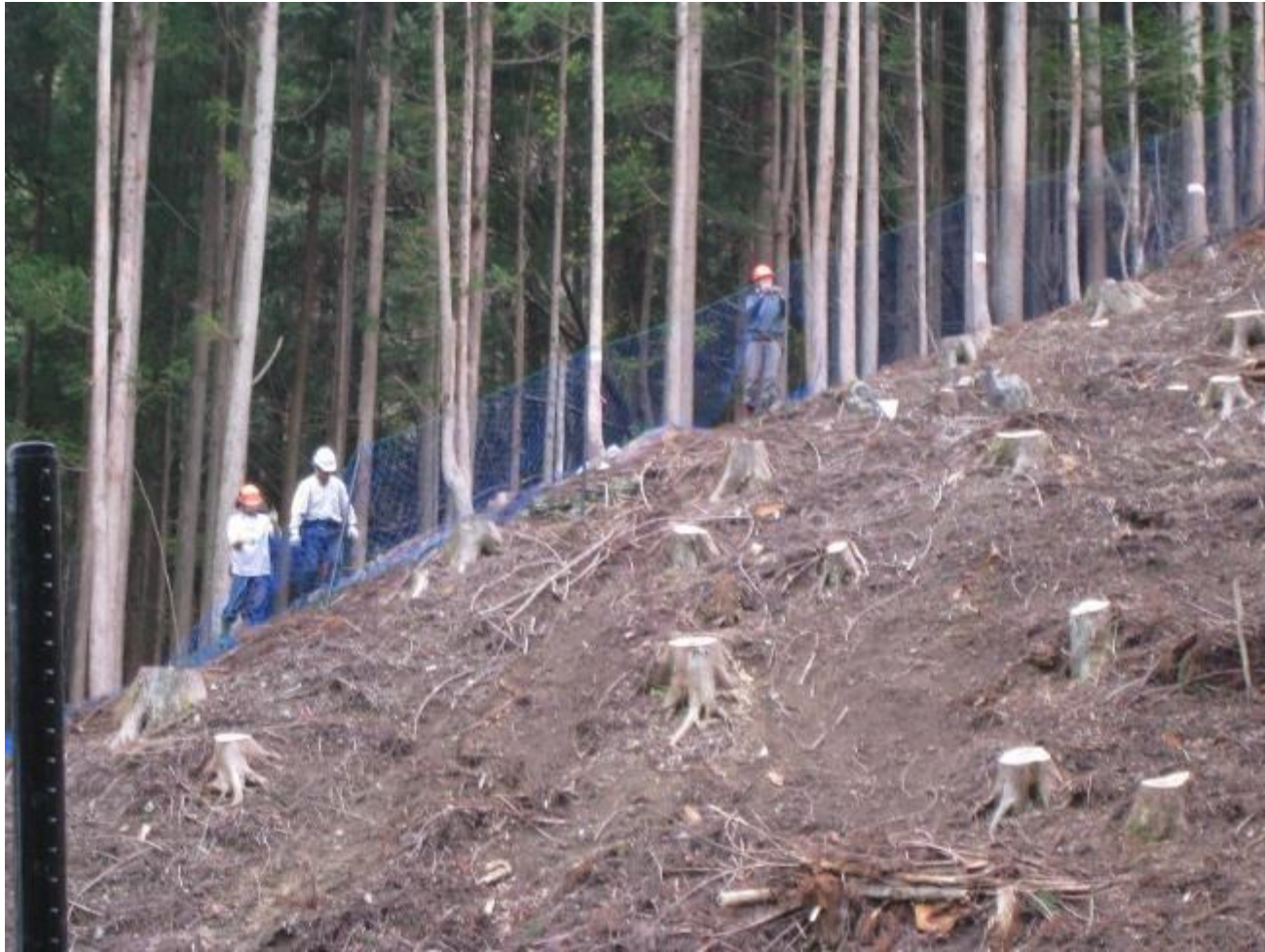
獣害防護柵設置(斜め張り柵)
