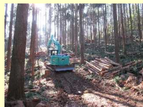
システム販売実施箇所
