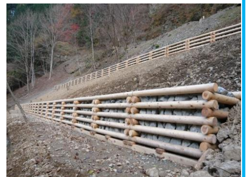
間伐材を使用した治山工事 (秩父市荒川上田野：中川国有林)
