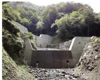
写真左:沢や谷の土砂の流出を防ぐ治山ダム (溪間工)
