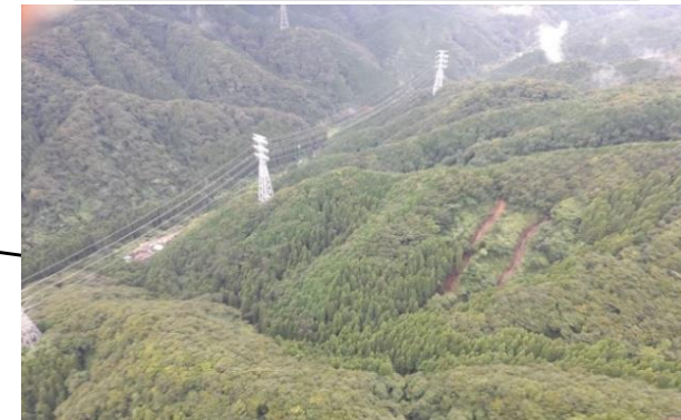
【国有林（日立市十王町 高原付近）】 県道60号線沿い上部で山腹崩壊が発生
