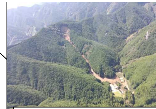
【民有林（静岡市葵区足久保口組付近）】 山腹崩壊が発生し、鉄塔が倒壊
