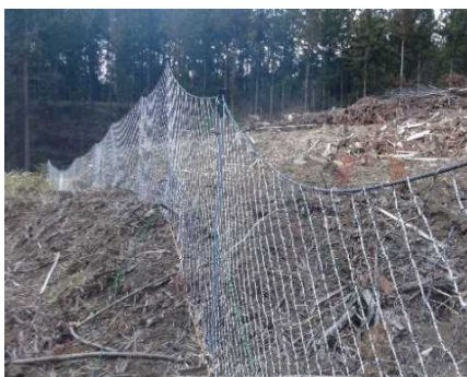
シカ侵入防護柵(日光署:日光市)
