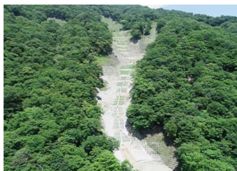
大規模崩壊地の復旧状況
