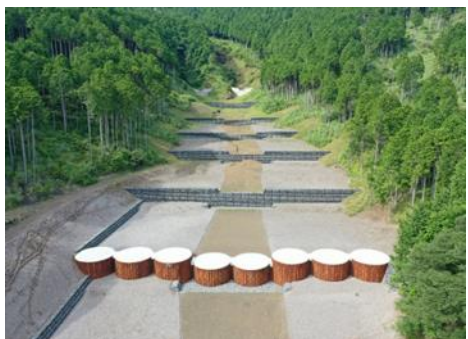
鋼製鉄板を使用した円形谷止工
