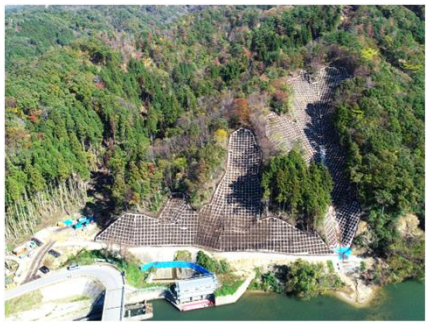
災害関連治山対策施工状況
