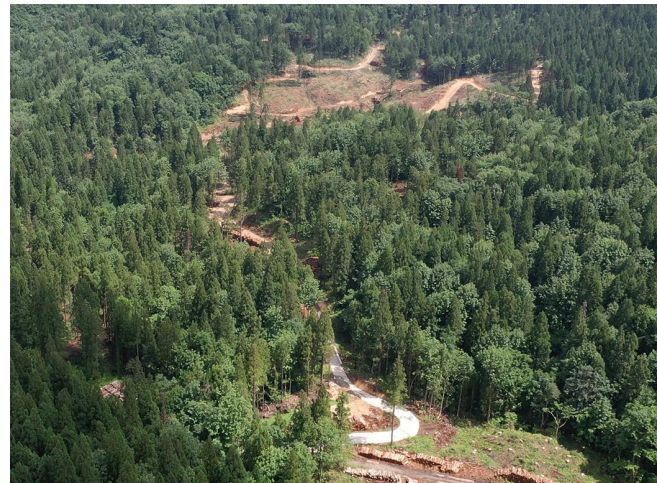
林業専用道（手前）と森林作業道
