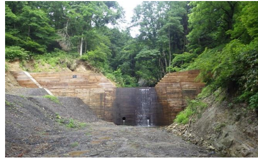
阿賀町土倉山（令和5年度竣工） 「コンクリート谷止」（木製残存型枠）
