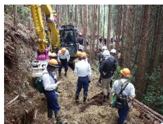
森林作業道作設の現地検討会
