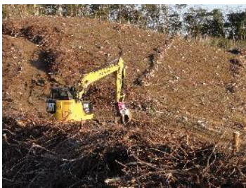
機械地拵実施箇所（常陸太田市）
