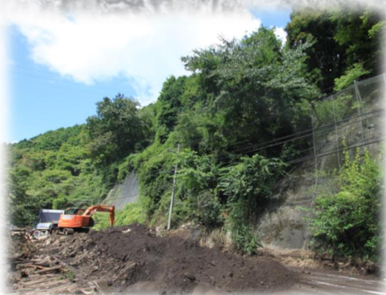
奥撫地区災害関連緊急治山工事 (日立市)
