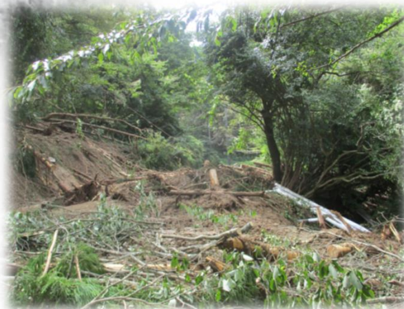
小松沢地区災害関連緊急治山工事 (日立市)
