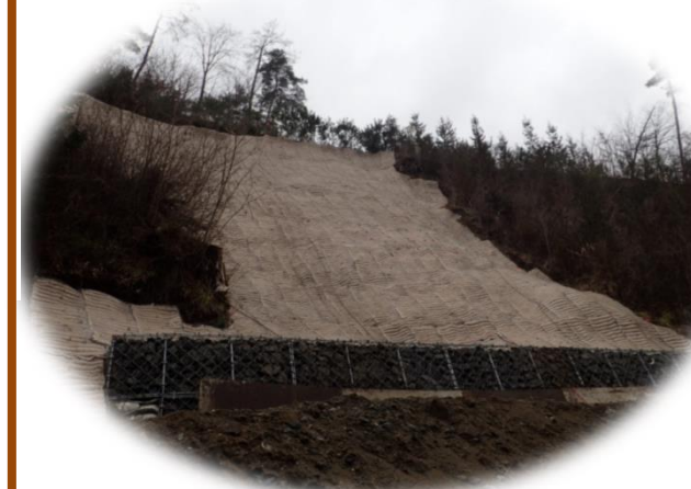
鍋足地区復旧治山工事 (常陸太田市)
