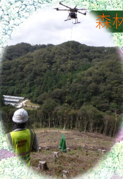
ドローンによる苗木運搬実証試験
