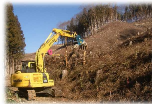
林業機械による地拵作業
