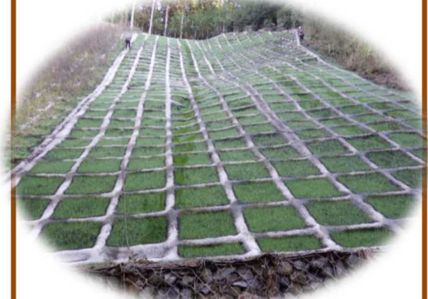
御前山地区復旧治山工事 (城里町)
