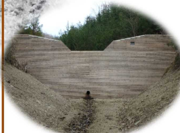
熊穴地区復旧治山工事 (常陸太田市)
