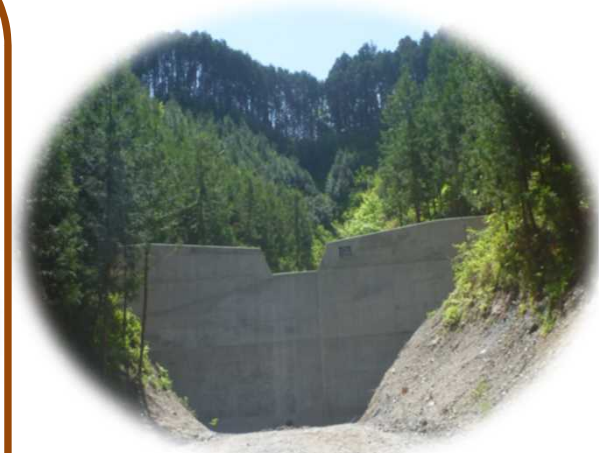
上高倉地区復旧治山工事
