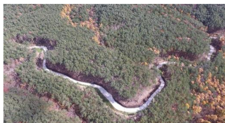
林業専用道の新設
