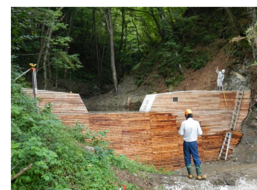
丸太残存型枠を用いた谷止工
