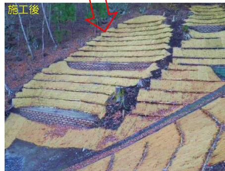
間伐材を利用した丸太積土工（利根沼田署:沼田市）
