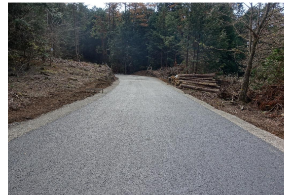
路網開設（大沢第二支線林業専用道）
