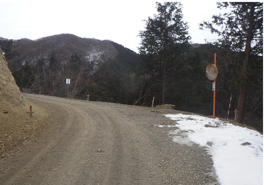
路網開設（谷山林業専用道）
