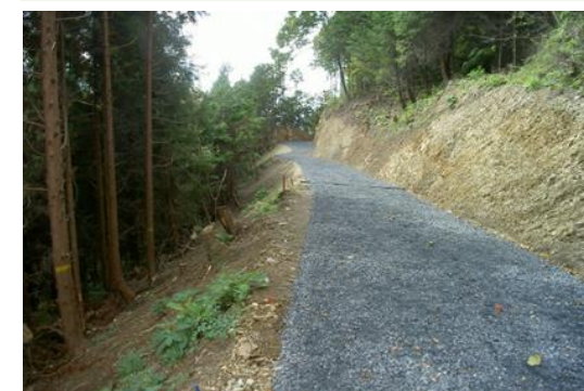
路網開設（西ノ沢林業専用道）
