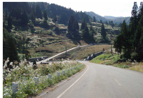
⑤ 音沢工区復旧状況
