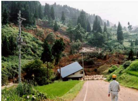
④ 音沢工区着手前(被害状況)
