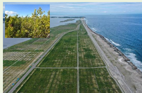
復旧の状況 (植栽されたマツと防風柵等)
