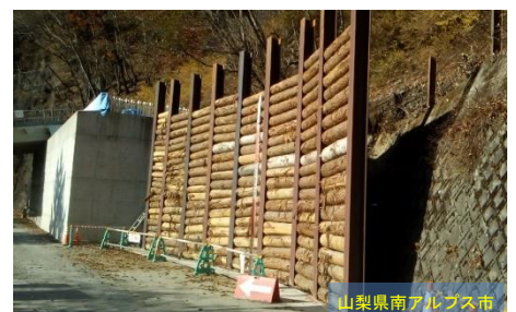
木材を使用した防護柵工
