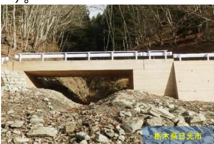
木材を使用した橋 (木製残存型枠)
