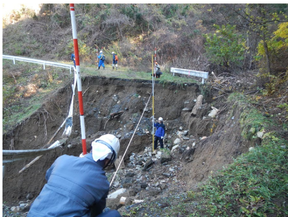
被災した民有林内の林道の復旧に向けた測量 (東北森林管理局)
