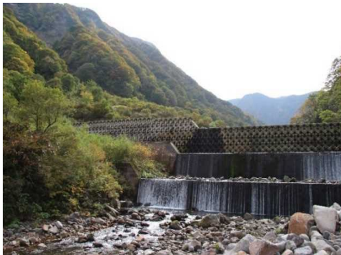
治山ダムを設置により山裾の土砂を堆積 (東北森林管理局)
