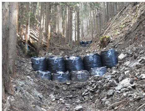
大型土のうを積んで、崩壊土砂の流出を防止 (東北森林管理局)
