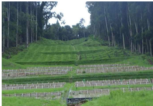
崩壊した斜面の安定を図り森林を再生 (九州森林管理局)
