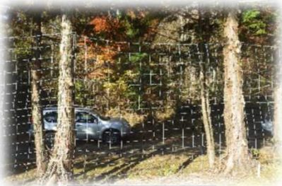
立木の支柱利用
