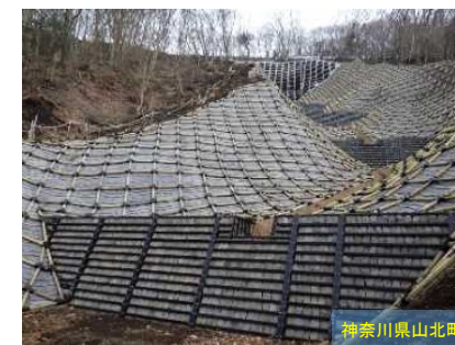
山腹工（土留工・法枠工）
