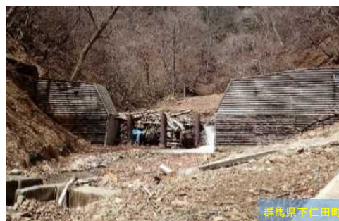
溪間工（谷止工による流木補足）
