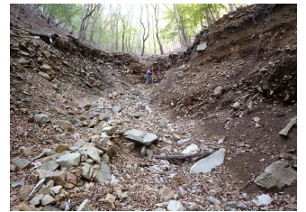
山腹工施工前の状況
